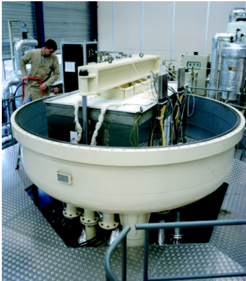
Een werkende stack van 10 kilowatt. Hier wordt waterstof en lucht omgezet in elektriciteit en water. De enige 'as' van deze elektrochemische reactie: schoon water.
